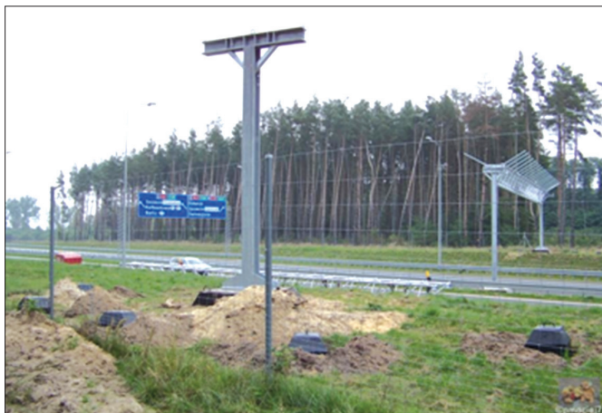
Fot. 4. Bramownice dla nietoperzy na odcinku trasy A2
