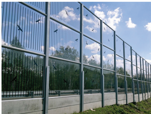
Fot. 2. Przykład prawidłowego nadruku na przezroczystym ekranie akustycznym – forma zmniejszenia śmiertelności awifauny – na przezroczystym ekranie są naklejone podobizny ptaków i pasy w gęstej odległości, które skutecznie zmniejszają widoczność drzew
